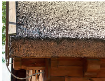
Fragment strzechy z widocznym ułożeniem trzciny (A.C.)
