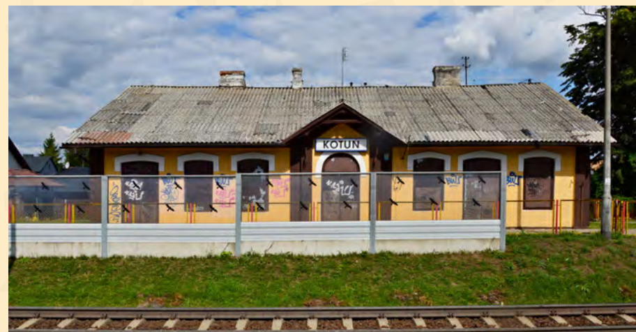
Zabytkowy budynek dworca PKP w Kotuniu
